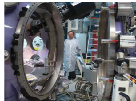
ادامه تجهیز تاسیسات در پروژه ELI
